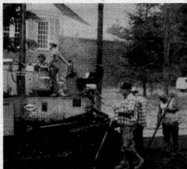
Ace Paving Co. crew
